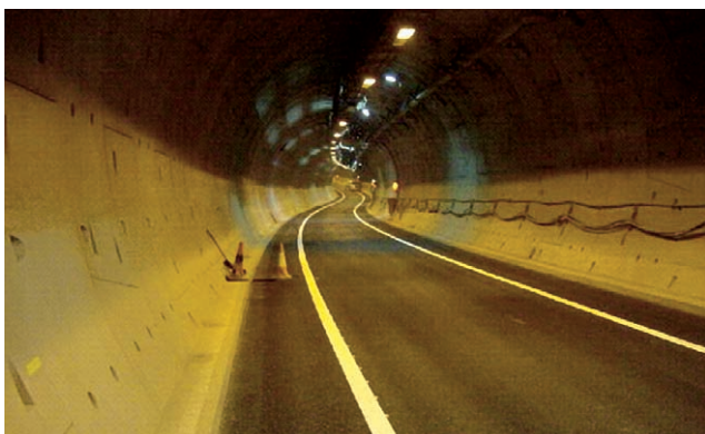
Obr. 8 – Tunel ART pred dokončením
