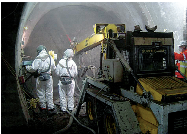
Obr. 7 – Ražba propojek metódou LaserShell
