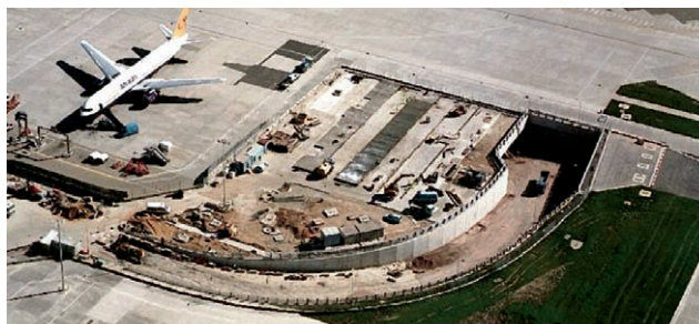
Obr. 2 – Západní portál tunelu ART
